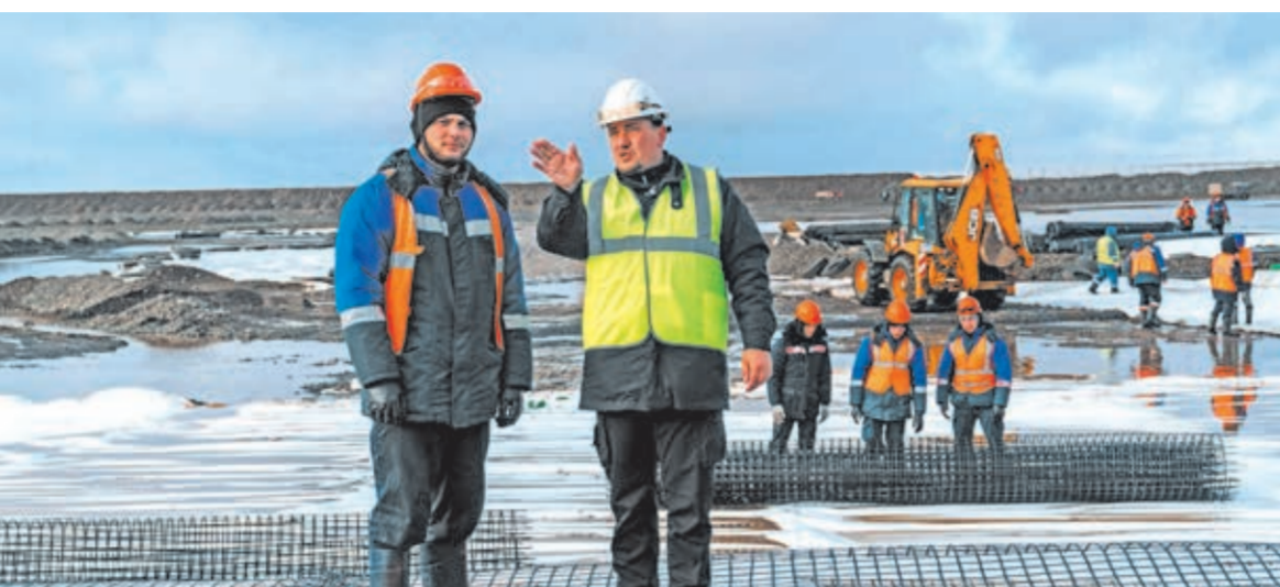
Главный инженер «ДТК Ямал» Евгений Моисеев (справа) руководит ходом работ на Буферной ёмкости Талнахской обогатительной фабрики. А Таймурат Джикаев (слева), студент архитектурно-строительного факультета СКГМИ, — бригадой стройотряда на укладке георешётки.
