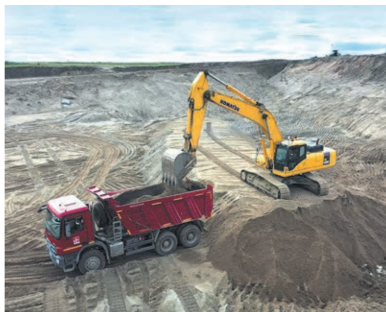
Для «Транс-Строй» оно течёт ровно и неуклонно. Дорожники чувствуют себя частью вечного круга созидания. «Северная-21» – символ непрерывного труда и мечты.
